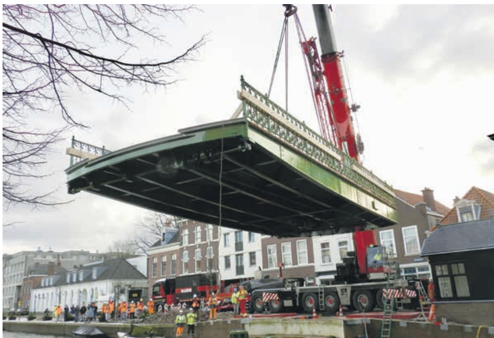
PLAATSING VAN HET BRUGDEK
