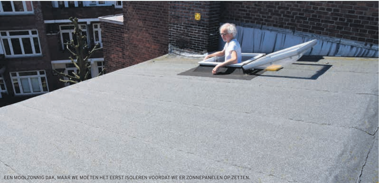
EEN MOOI ZONNIG DAK, MAAR WE MOETEN HET EERST ISOLEREN VOORDAT WE ER ZONNEPANELEN OP ZETTEN.
